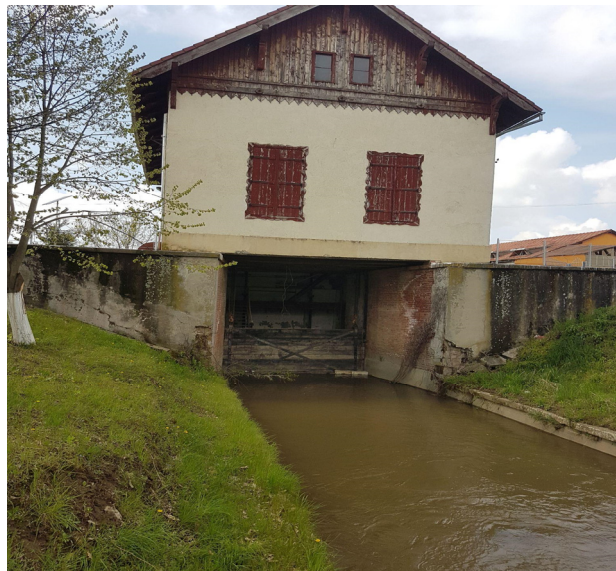
Fotografia 6.6. Zona din amonte casei stăvilar.
