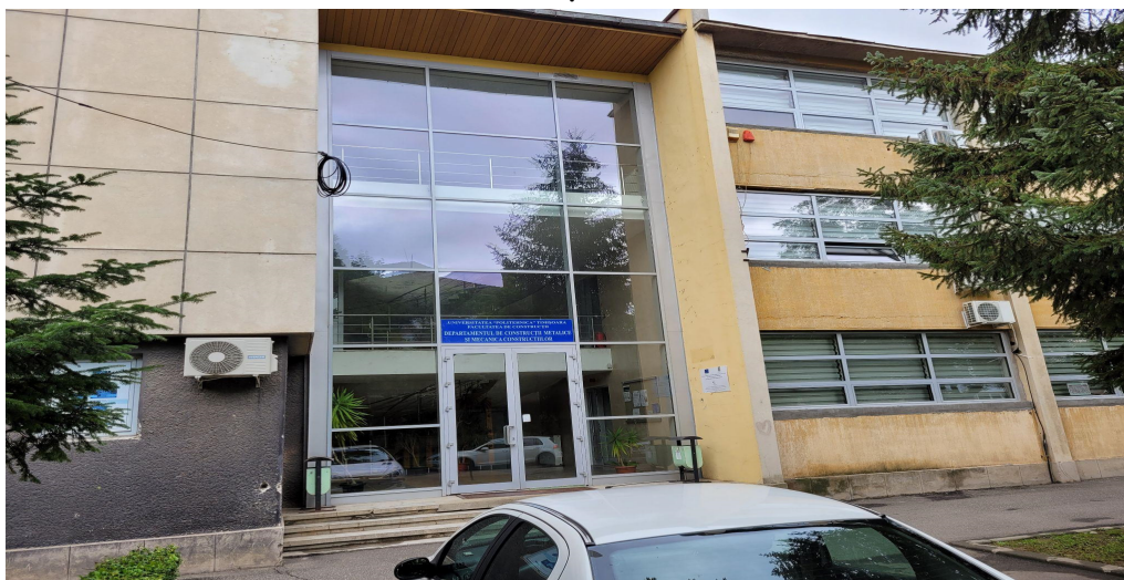
Fotografia 8.9. Departamentul de Construcții Metalice și Mecanica Construcțiilor.
