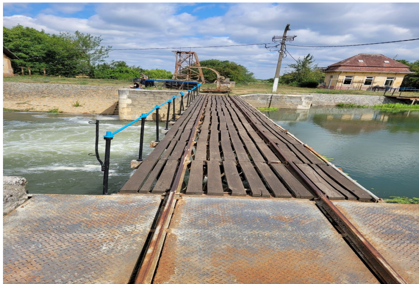
Fotografia 7.5. Calea de rulare și dispozitivul de acționare a barajului de la Uivar.
