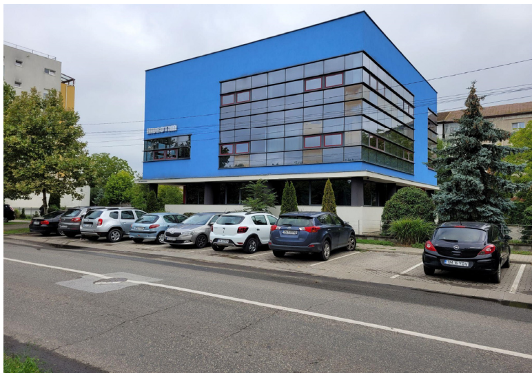
Fotografia 10.6. Sediul actual al Hidrotim.
