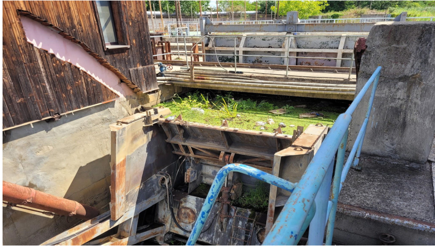
Fotografia 7.8. Stavila cilindrică, batardoul din amonte ei și pila care conține noul sistem de acționare hidraulică a stavilei.
