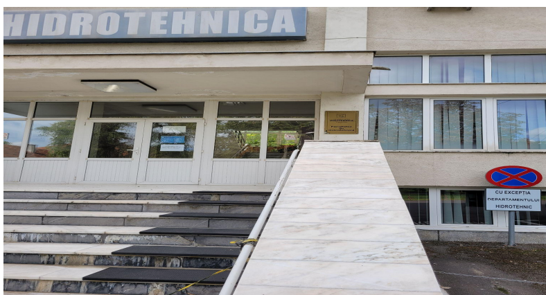
Fotografia 8.12. Facultatea de Construcții Hidrotehnice
