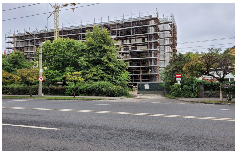
Fotografia 10.8. Starea clădirii în vara anului 2022.
