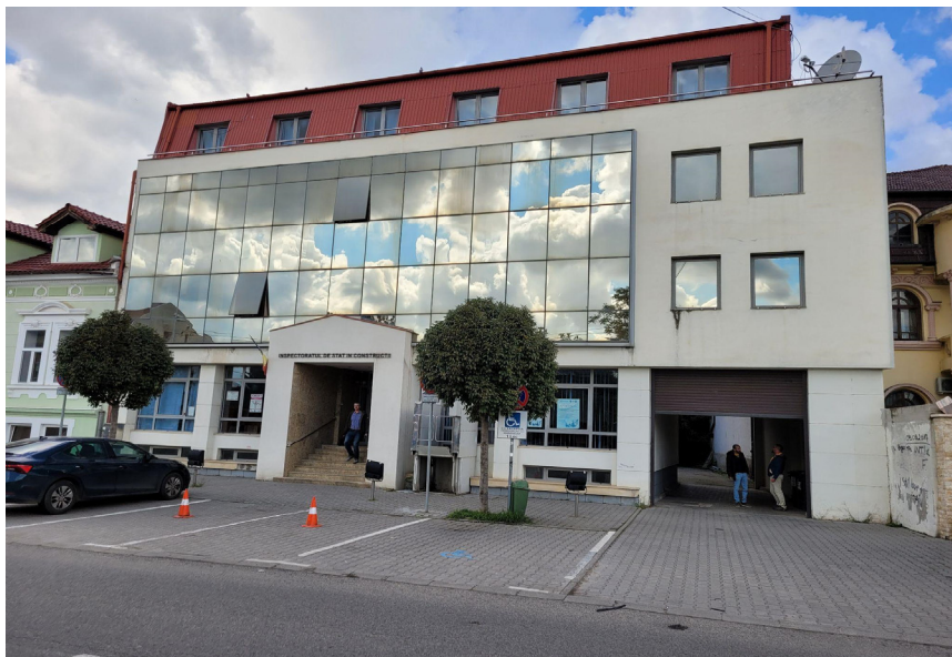
Fotografia 10.9. Inspectoratul de Stat în Construcții.
