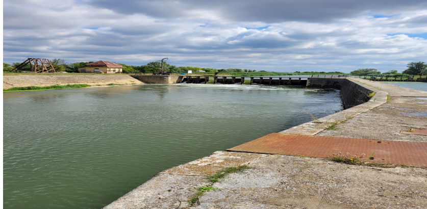
Fotografia 7.4. Barajul Uivar, văzut din aval.
