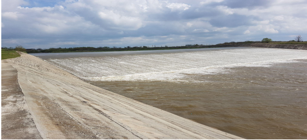
Fotografia 6.5. Barajul deversor actual (2022).
