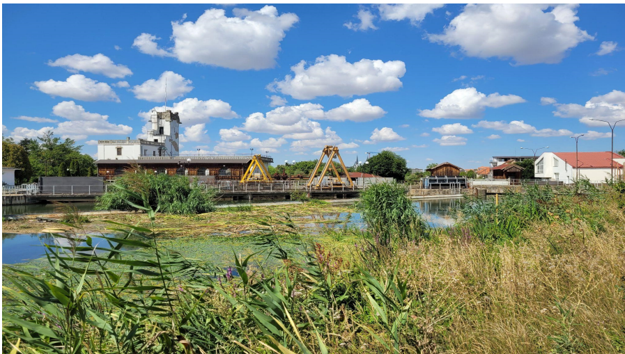
Fotografia 7.9. Nodul hidrotehnic Timișoara văzut din amonte.
