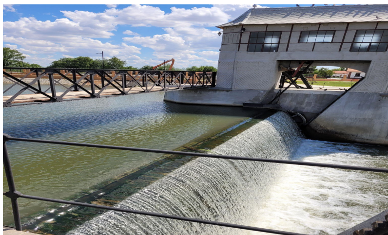
Fotografia 7.2. Stavila deversoare și pila centrală de la Sânmihai.
