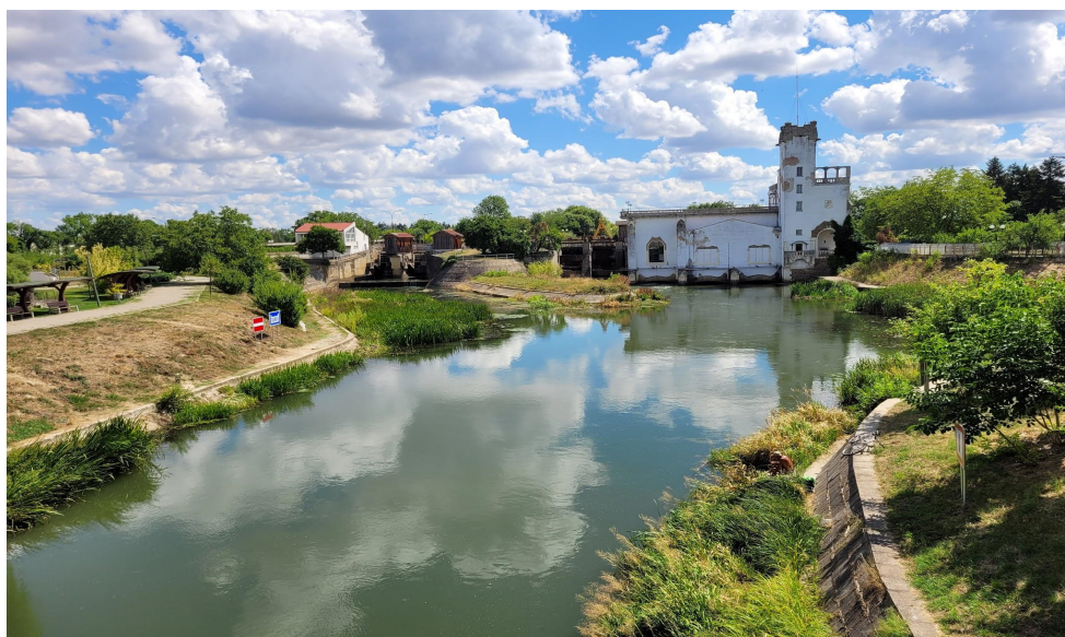
Fotografia 7.10. Centrala electrică, insula și barajul deversor.
