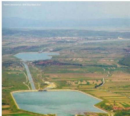
Amenajarea hidroenergetică Râul Mare – Retezat [Sursa: Hidroelectrica Hațeg]
