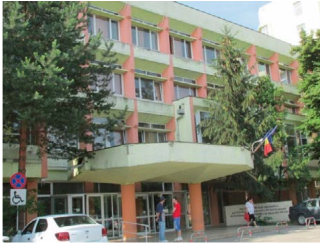
Sediul actual al Facultății de Electrotehnică și Energetică
