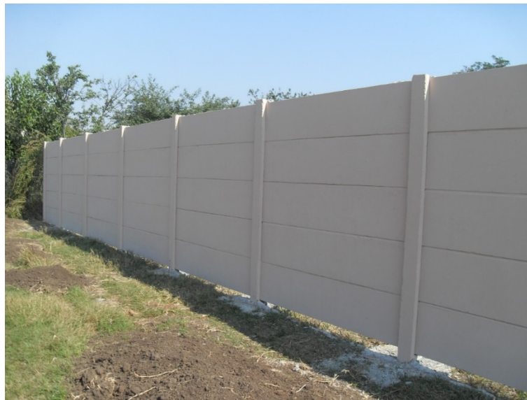
Fig. 7.7. Gard din plăci amovibile de beton
